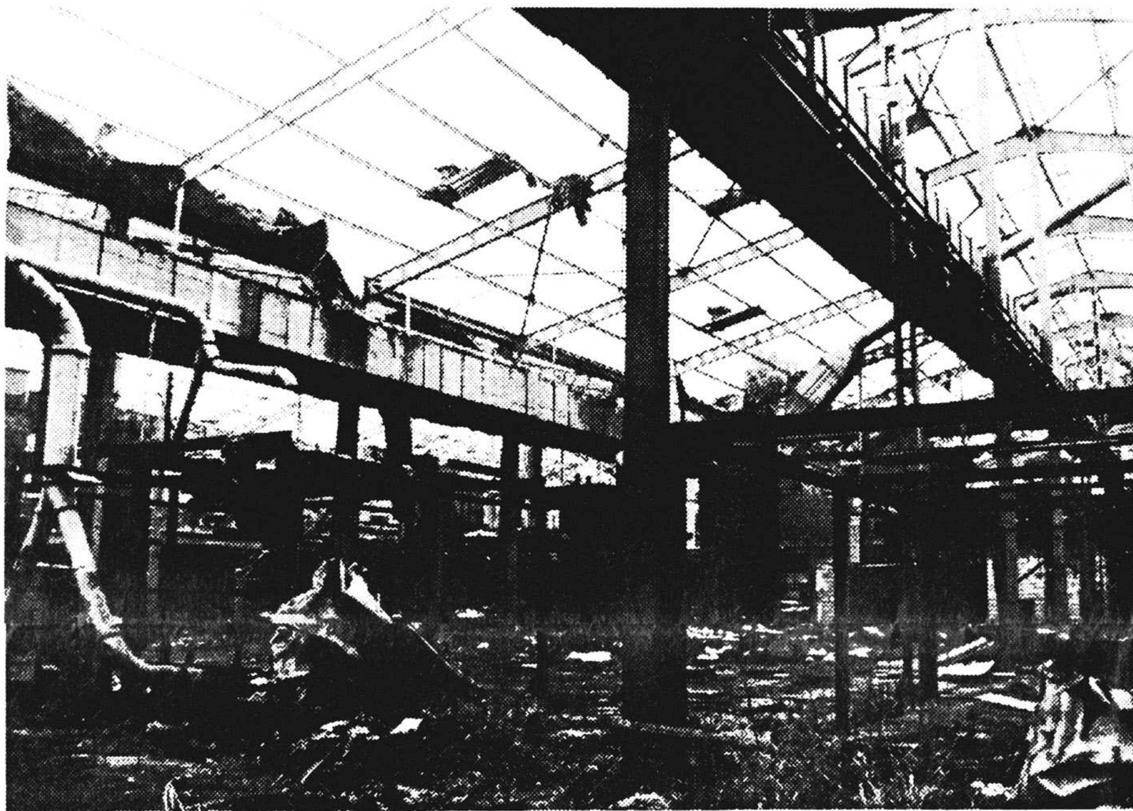
Einst eine Fabrik
